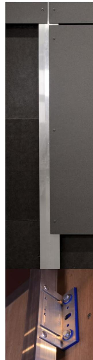
Соединения в металлической опорной раме должны совпадать с соединением панели.
